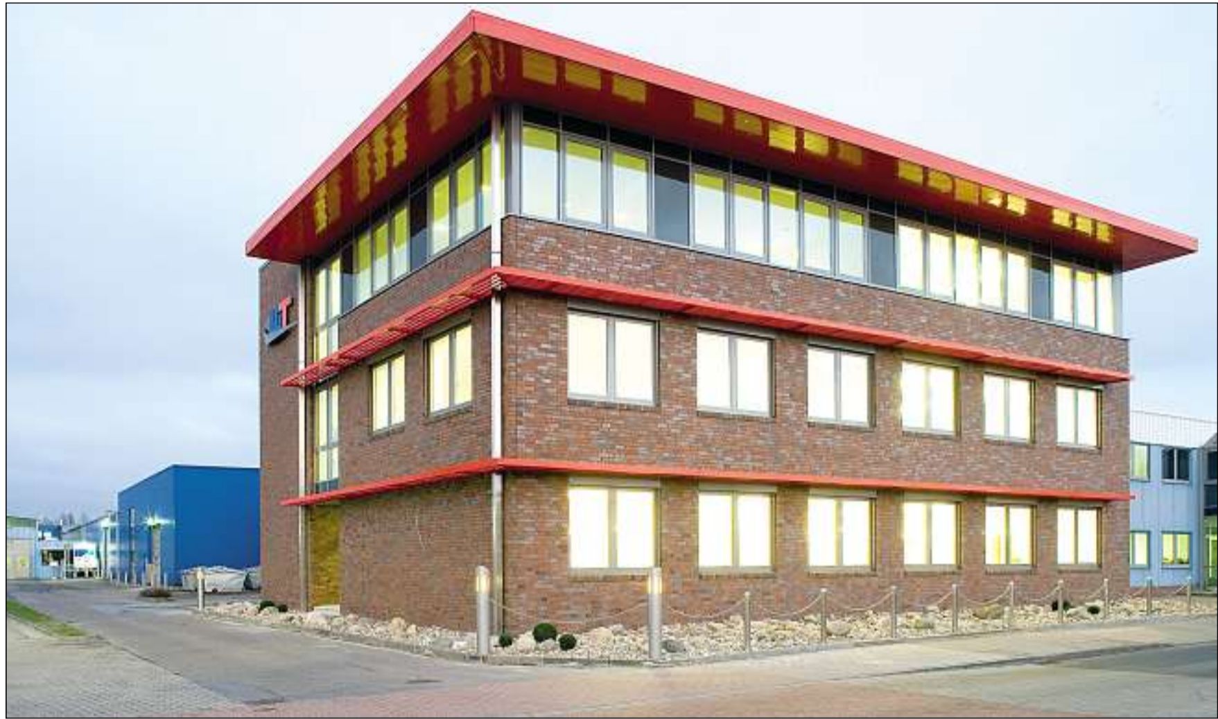
Das neue Verwaltungsgebäude der Firma »Wiedemann GmbH« ist ein moderner Bau, der sich in die Industrielandschaft des Gewerbegebietes gut integriert. FOTOS: PRIVAT
